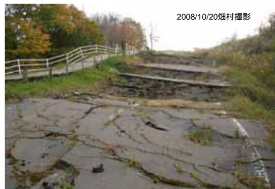
写真10 町道泉公園線 (写真向うが隆起し、手前がずれ落ちたので、道が階段状になった。)
