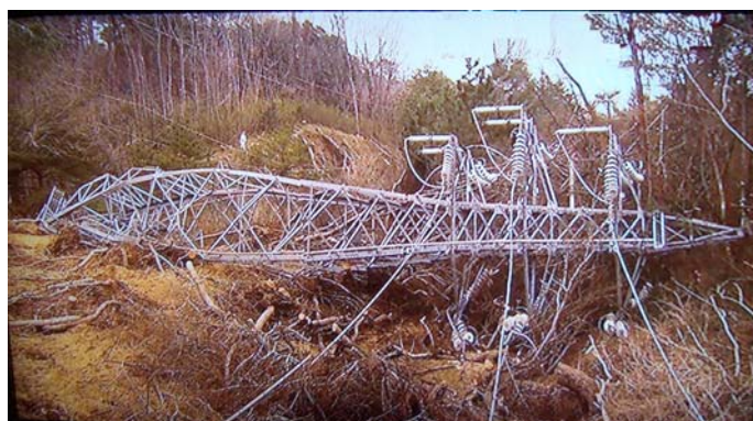
5・6号機用の受電鉄塔倒壊 （いずれも東電撮影）
