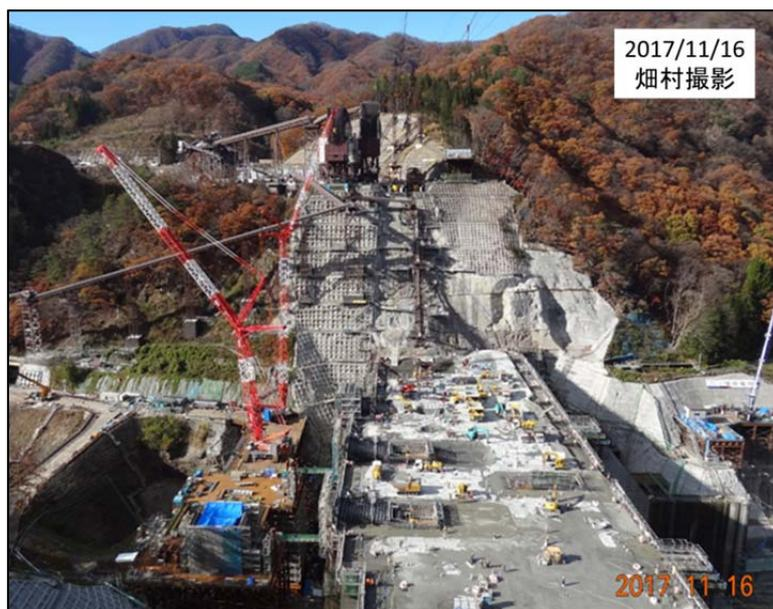
図2 ダム右岸天端から見たダム本体工事
