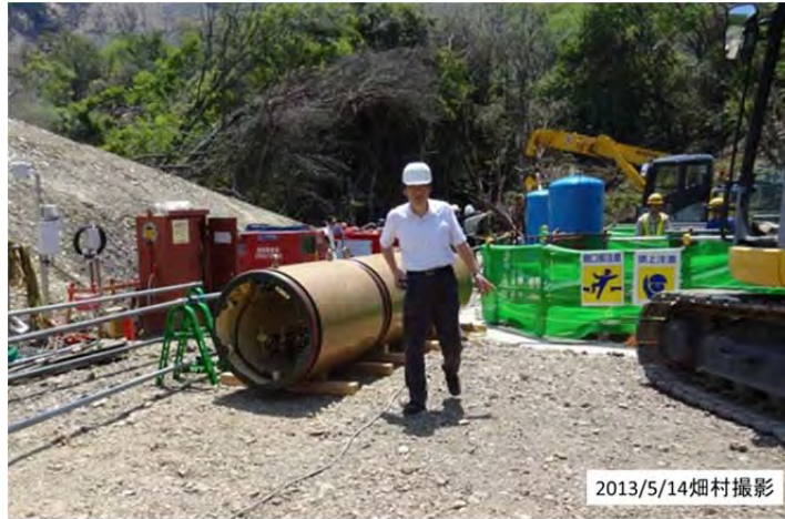
堤部分の通水に推進管工法を使っていた。
