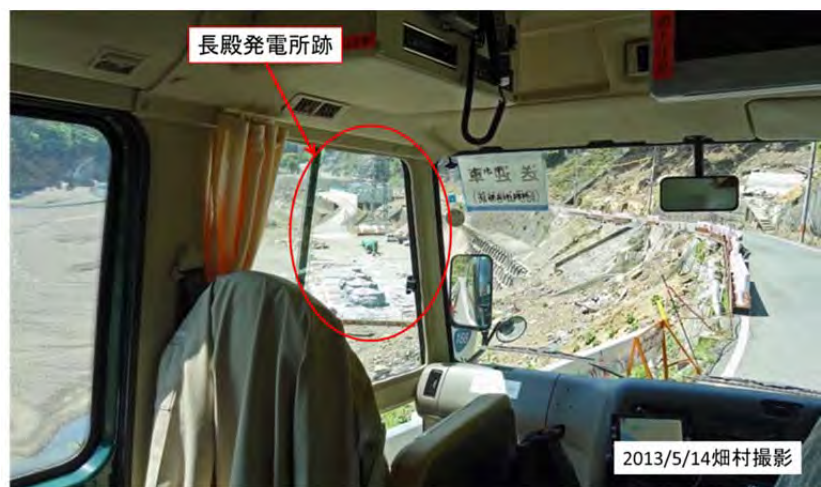
土砂崩壊でできた湛水池にさらに上流で起こった崩壊の土砂が落下し、津波が起こって発電所を破壊した。
