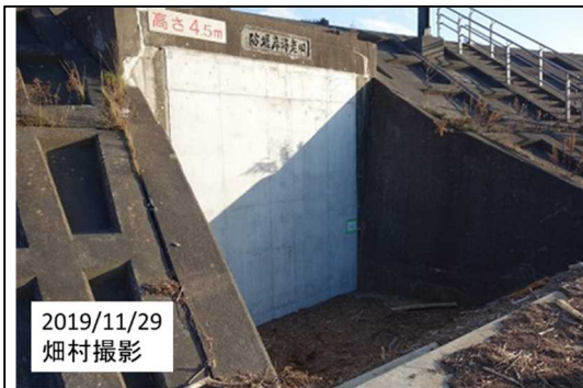
図10 田老防潮堤の閉じられた通り抜け門を居住区側から見る
