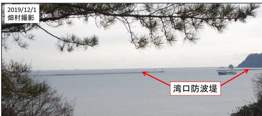
図27 釜石観音から遠望した左右の釜石湾口防波堤
