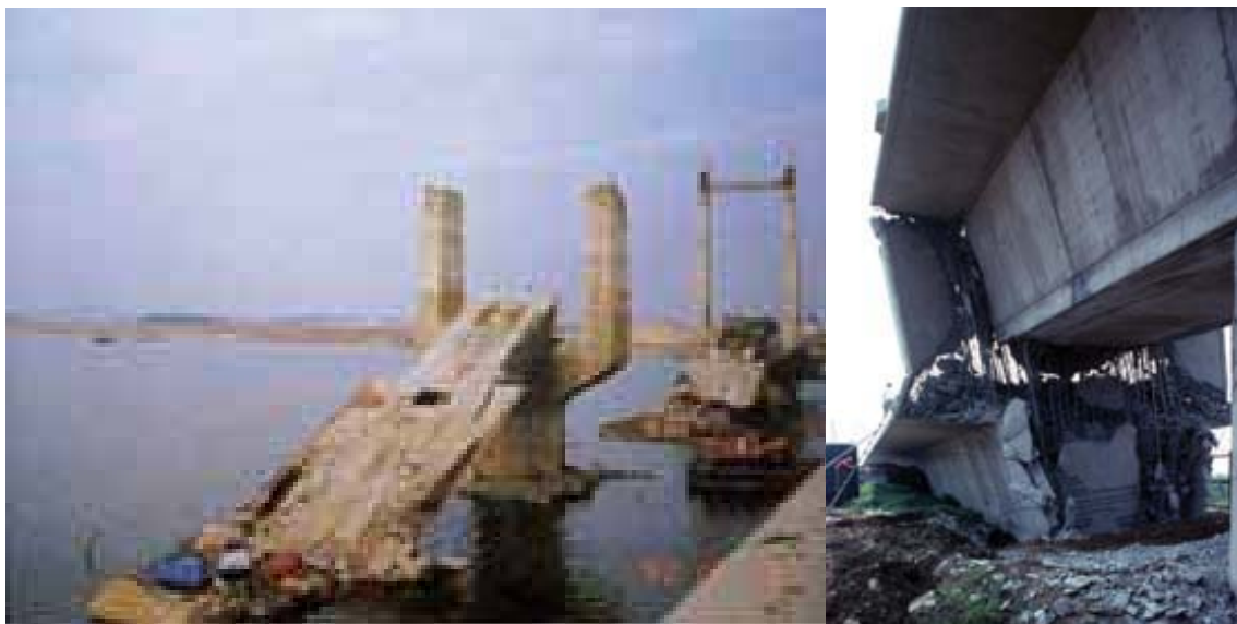
写真－1 新幸州大橋の崩落事故直後の状況
