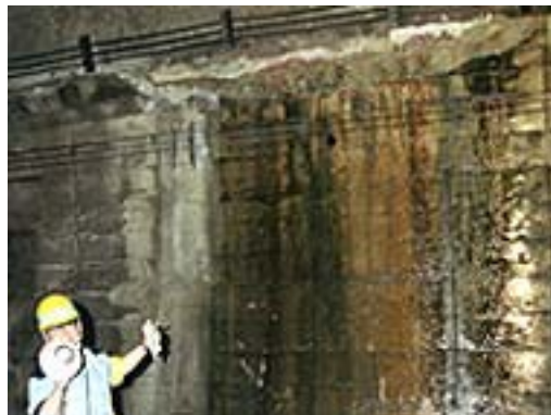
図 1 . 北九州トンネル剥落現場 （出典；中国新聞）
