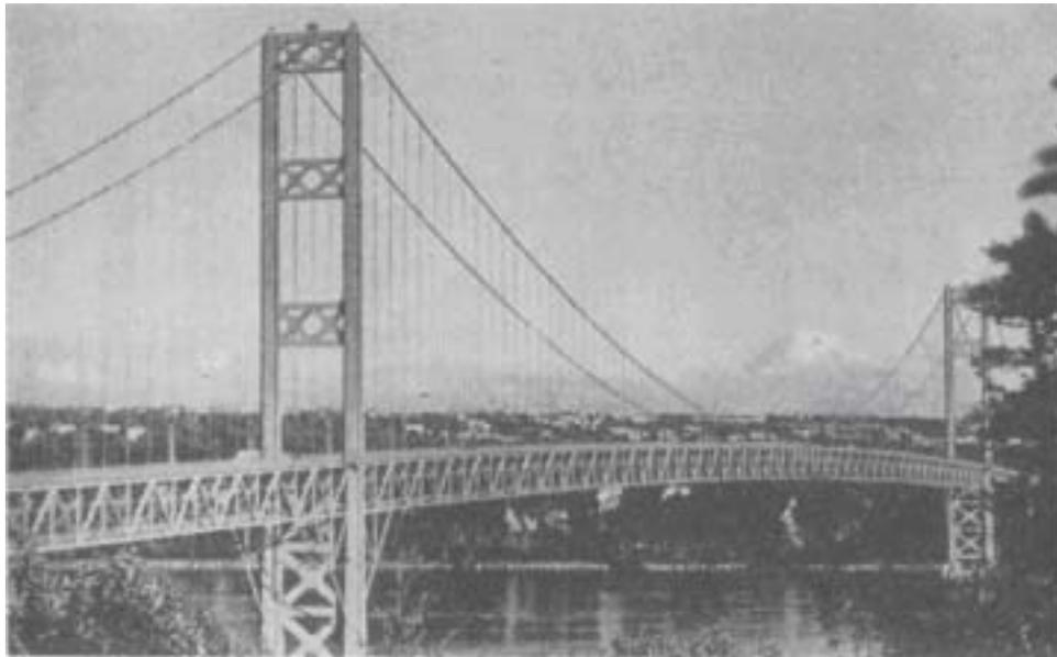
写真 4 新タコマ橋（橋桁がトラス構造になっている） [1]
