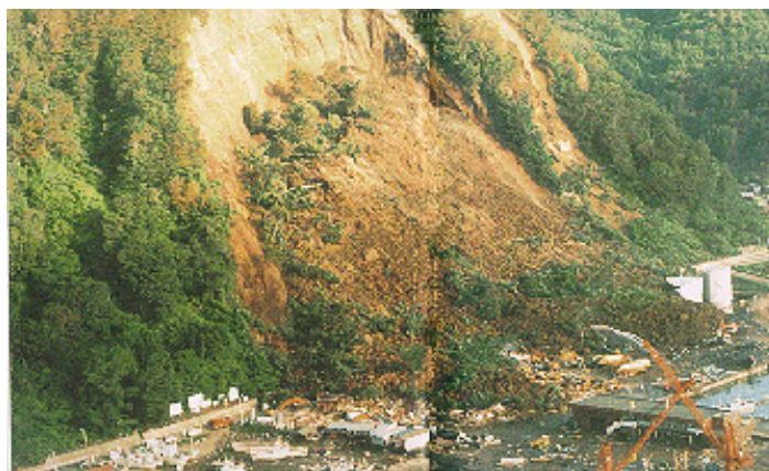
写真 2 奥尻地区山崩れ状況 [1]
