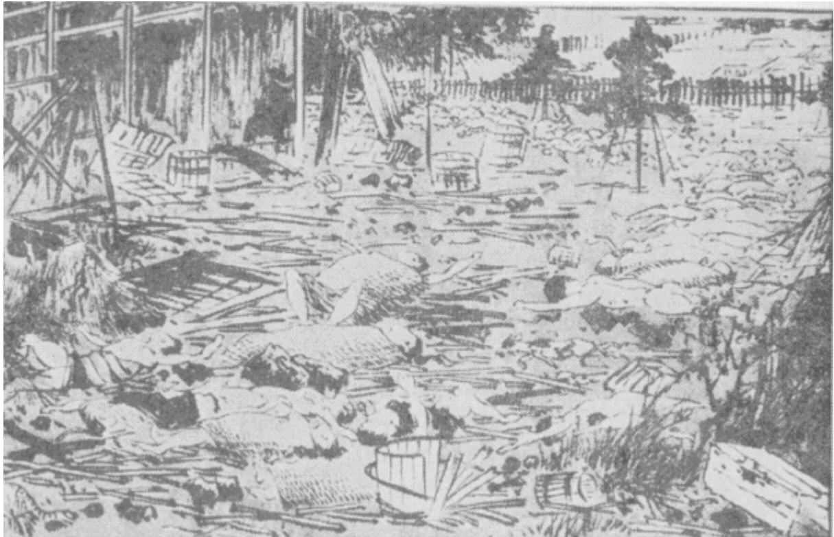
図1 釜石町津波被害後の状況 [1]
